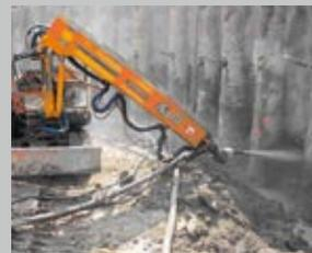
Der Spritzmanipulator AL-302 aufgebaut auf einem Kleinbagger ist die ideale Kombination um mit der AL-267 eine grosse Leistung, bis zu 21 m³ pro Stunde, zu fördern. Baugruben- und Felssicherungen sowie andere Anwendungen können damit effizient und ökonomisch ausgeführt werden.
