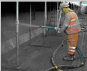
Betonsanierungen mit Spritzbeton im Trockenspritzverfahren garantieren eine gute Haftung des Materials und eine ausgezeichnete Verdichtung. Je nach Anforderung kann die AL-237, die AL-257 oder die AL-267 eingesetzt werden.
